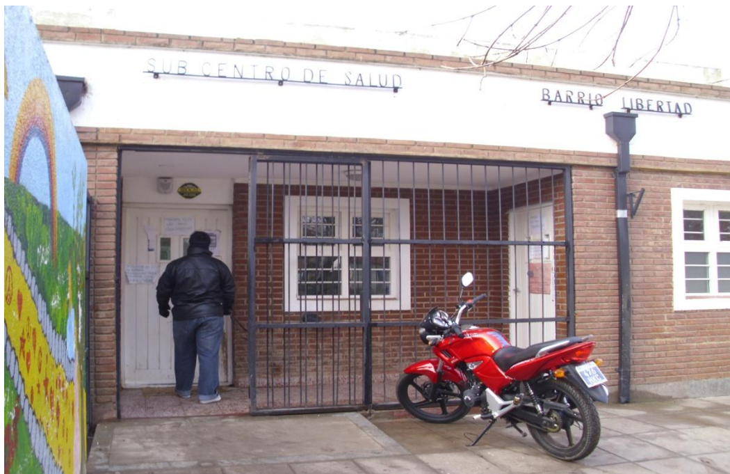
Fachada del Subcentro
