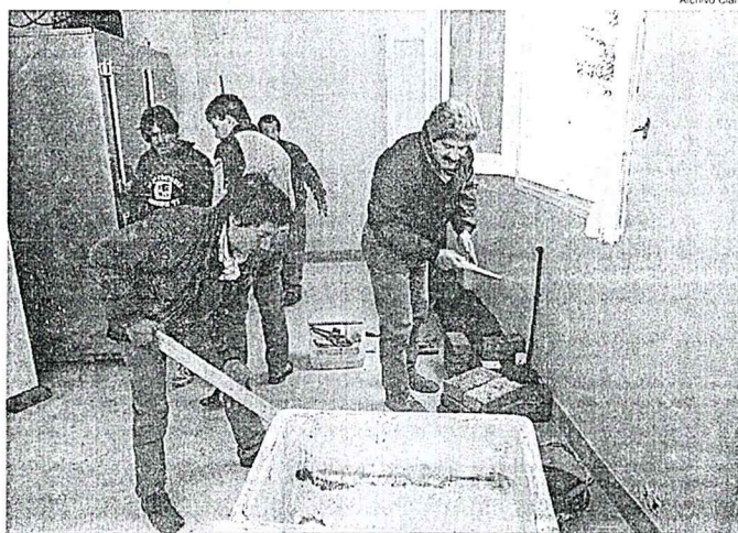
TRABAJANDO. Beneficiarios del Plan Trabajar arreglando un hospital.
